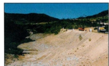
시공 전(세븐힐스G.C. 진입로)
