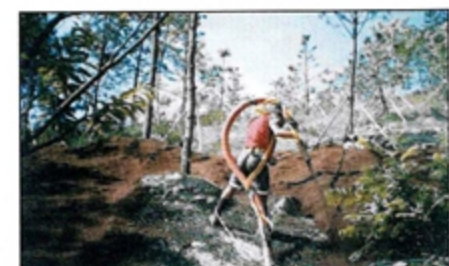
PEC4공법 시공 장면(노블카운티)
