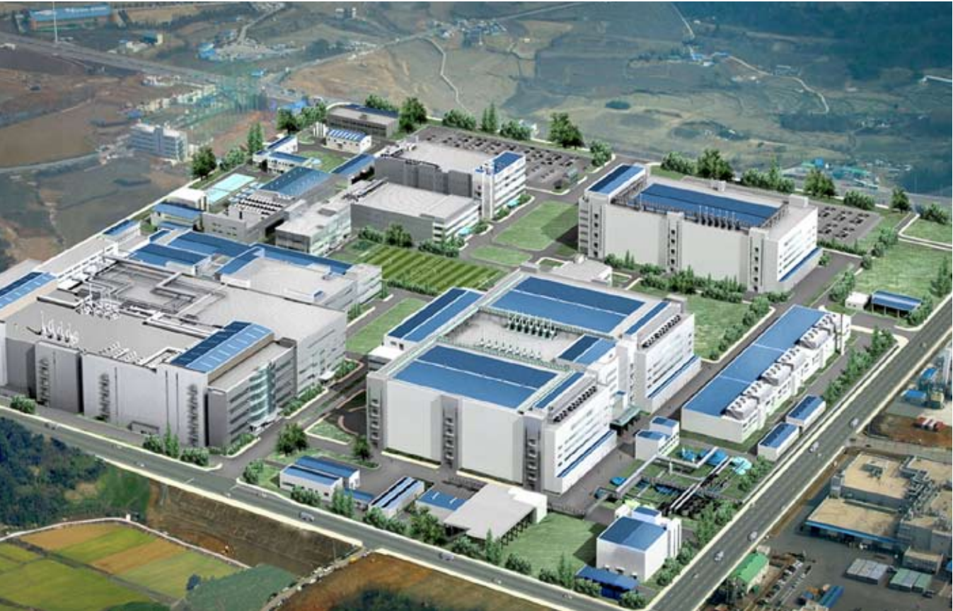
▶ 천안전자단지 소방 / 승강기 공사
